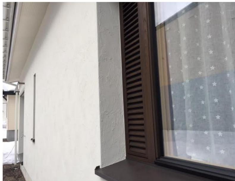
旭川の30cm厚の断熱（充填断熱＋2層外張り）。 $U_A < 0.2 \text{ W/m}^2\text{K}$ に相当。
